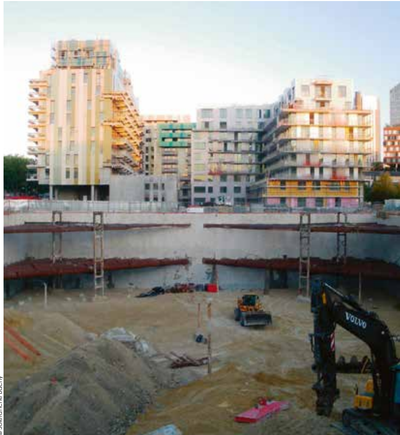
Mise hors d'eau d'une fouille en bord de Seine – Boulogne-Billancourt.
